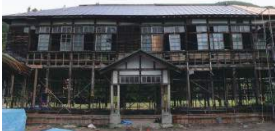
改修工事中の校舎
