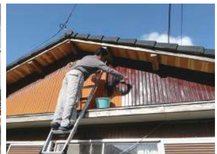
移住体験住宅改修の様子
