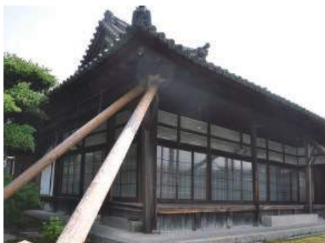
支柱で補強された「達磨寺方丈」
