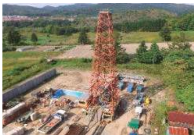
CBM試掘現場
